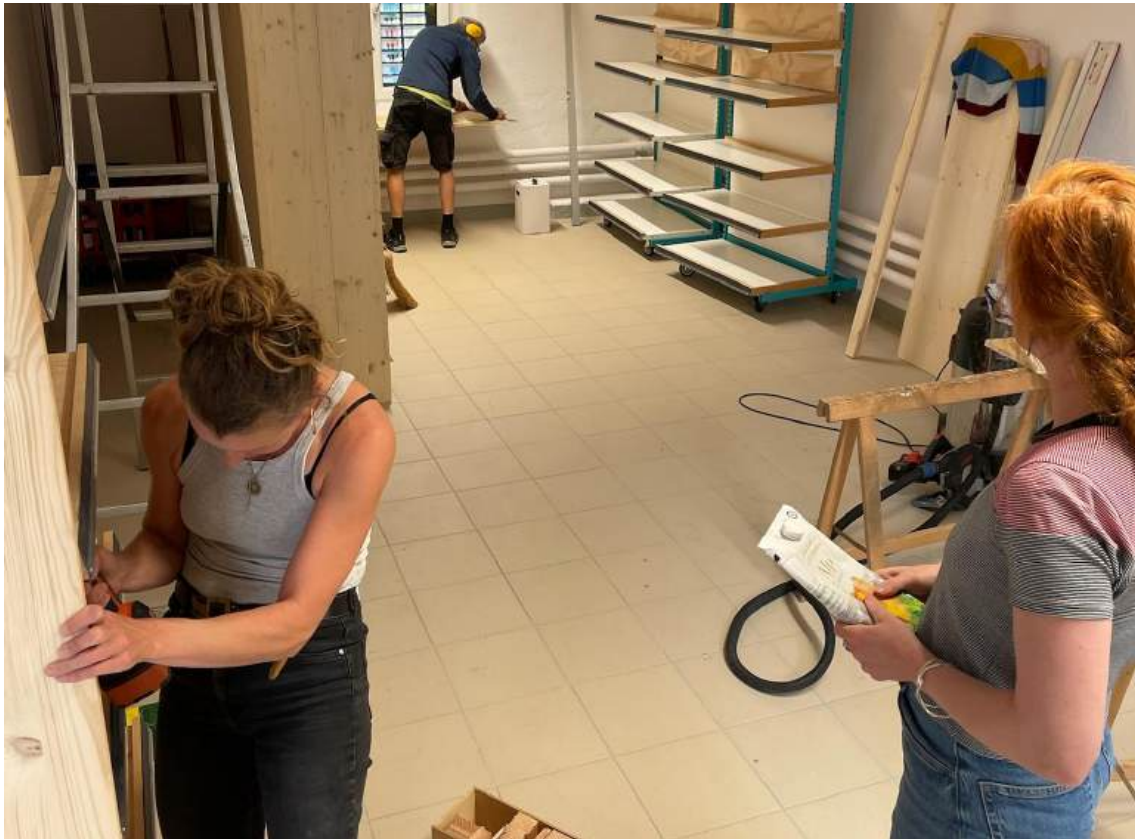
Der neue Boden liegt, Regale im Aufbau
